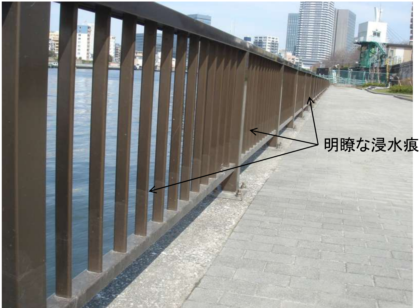
隅田川(測定地点1)の津波痕跡(手すり柵)
