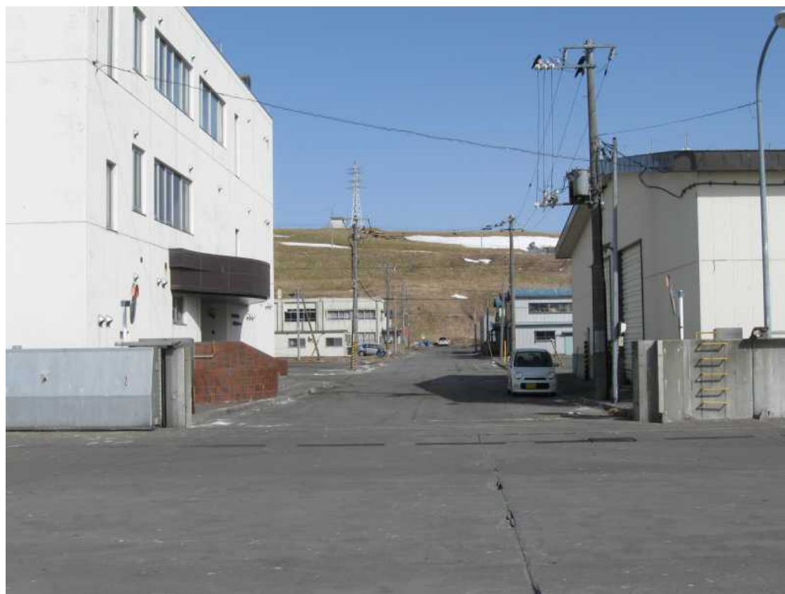
防潮壁・防潮ゲート
