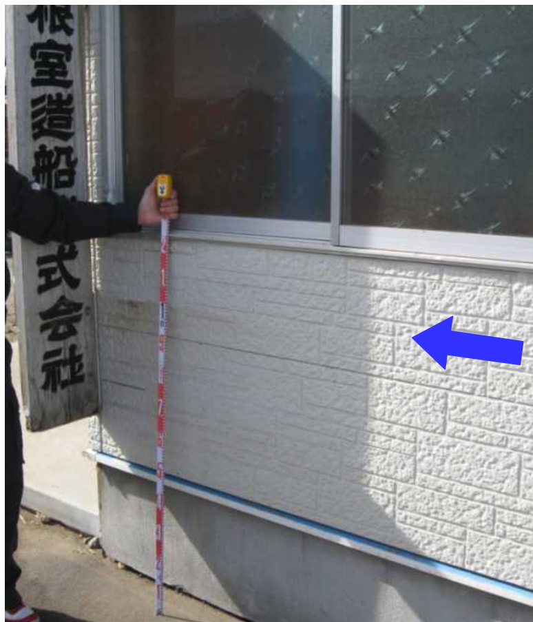
防潮壁の外側にある建物
