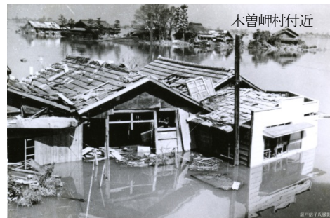
木曾岬村付近 提供：木曾川下流河川事務所 写真1-4 被災した家屋
