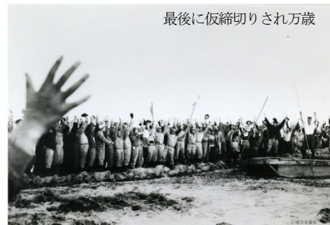
最後に仮締切りされ万歳 提供：木曾川下流河川事務所 写真1-6 長島町白鷺の仮締切りの完成
