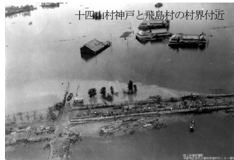
十四山村神戸と飛島村の村界付近 提供：木曾川下流河川事務所 撮影：陸上自衛隊 写真1-2 被災した十四山村付近
