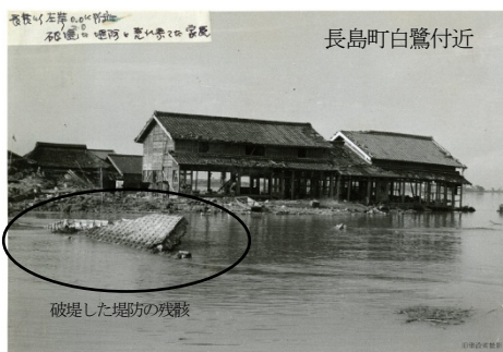
長島町白鷺付近 提供：木曾川下流河川事務所 写真1-5 揖斐川左岸の破堤した堤防と家屋
