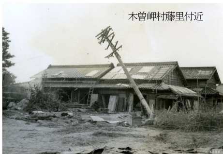
木曾岬村藤里付近 提供：木曾川下流河川事務所 写真1-3 被災した家屋と電柱
