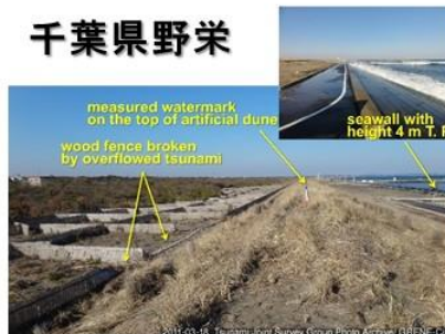
図-1 津波痕跡水位の標高（右）と堤防の破壊状況（左）
