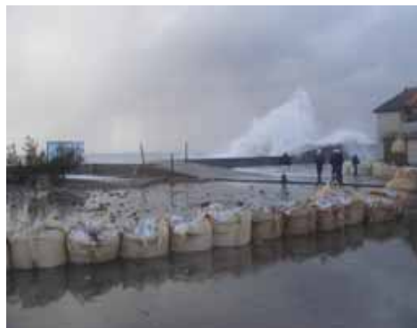
事例：土嚢設置 (富山県下新川海岸)
