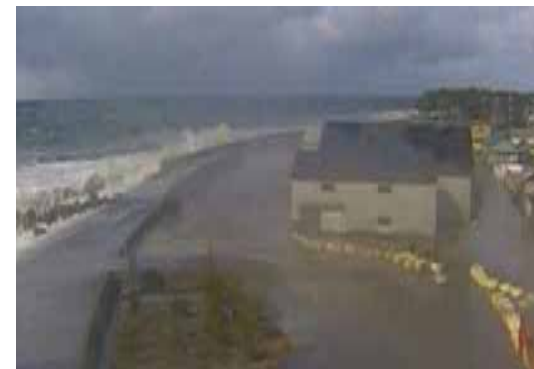
事例：CCTVによる監視 (富山県黒部市)
