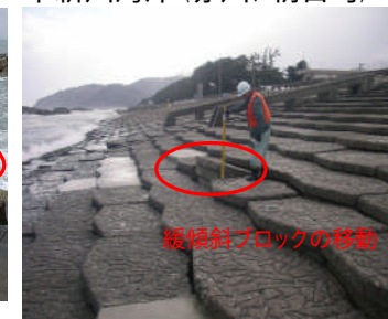
緩傾斜ブロックの破損
