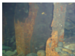
基礎矢板の損傷
