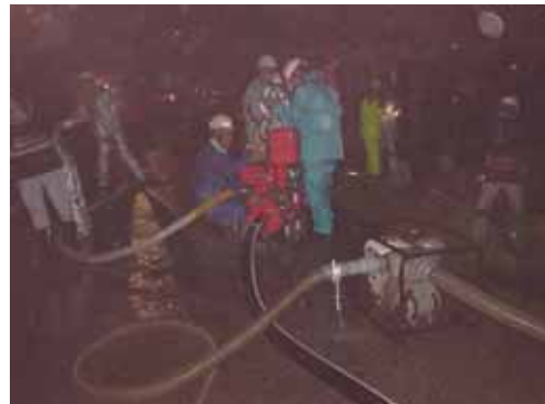
事例：ポンプ排水(愛媛県出走海岸)
