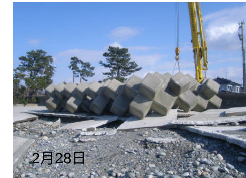
被災箇所へのブロック投入 (入善町芦崎)
