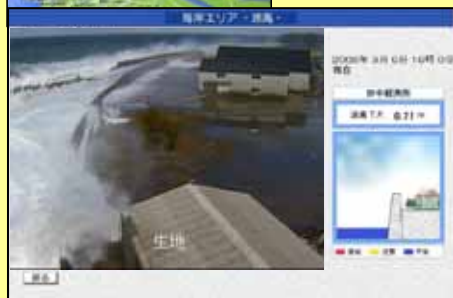
黒部市生地地区の越波状況
