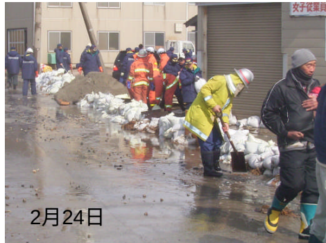
積み土のう工の実施 (黒部市生地)
