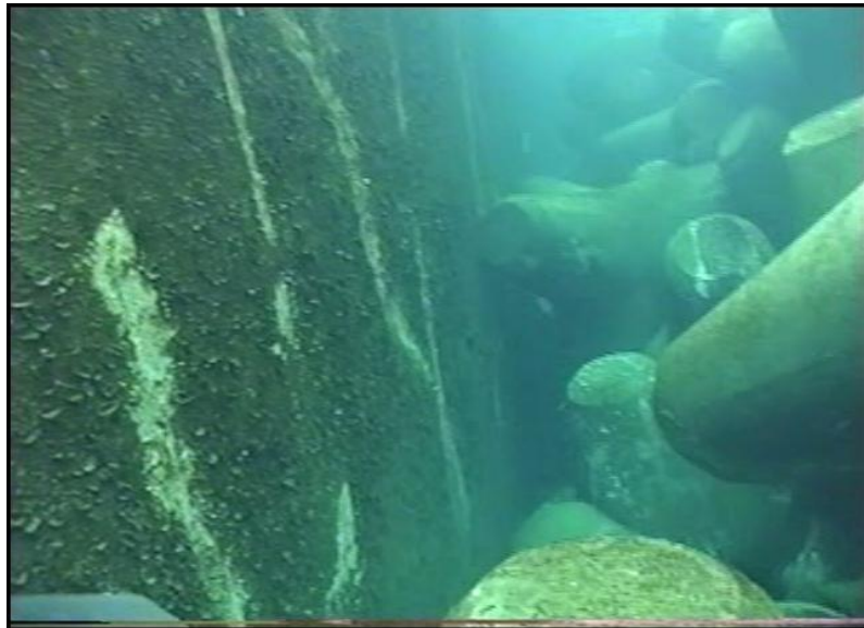
消波ブロックによるケーソンの傷
