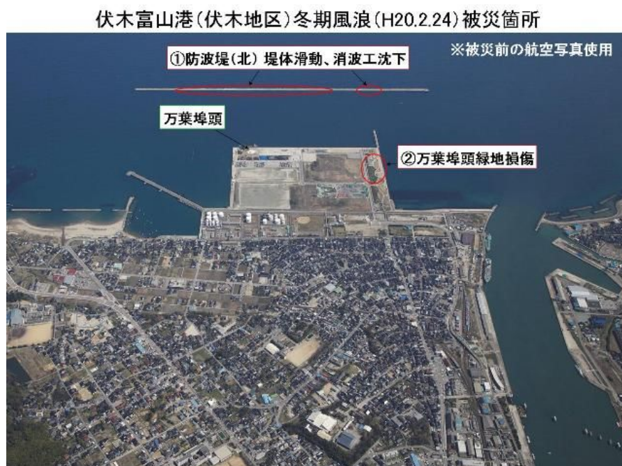
図 2-1 伏木富山港（伏木地区）における主な被災箇所
