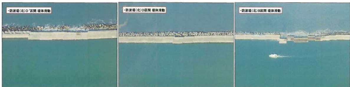
図 2-5 北防波堤の被災状況 (D'、D、B、区間)
