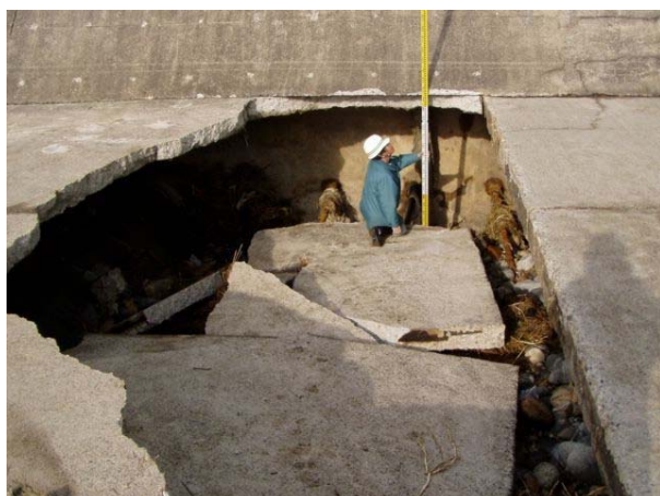
【③護岸の中詰めが吸い出された例】平成 16 年 2 月 22 日 新湊
