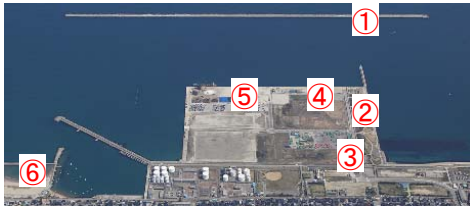
①伏木地区 北防波堤
