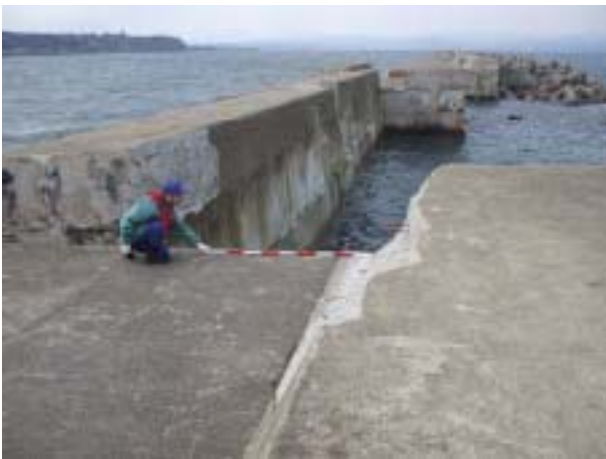
(a) 消波ブロックの飛散・衝突による上部工欠損 (b) B 区から A 区（堤頭部）を望む 写真 伏木地区防波堤（北）の被災状況
