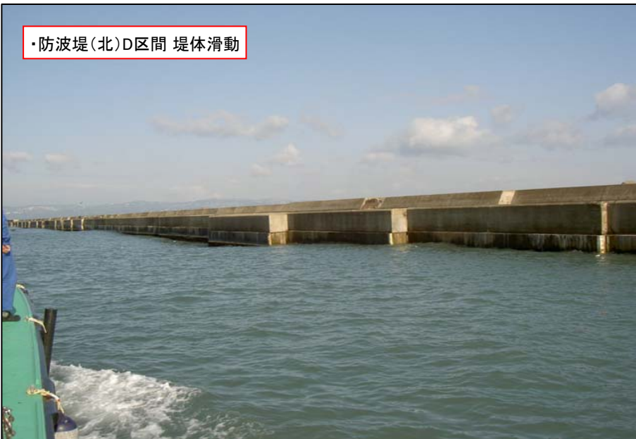
・防波堤(北)D、D'区間 堤体滑動
