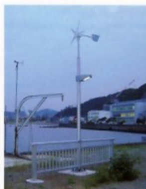
沿岸風力照明支柱
