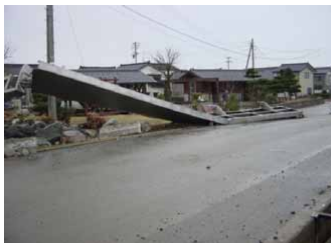
りっこうもんび 陸閘の門扉の飛散(入善漁港海岸)
