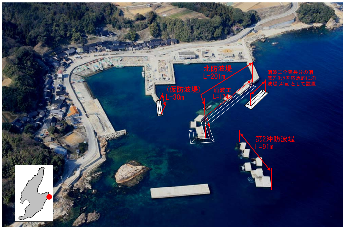
図 V-1-3 新潟県水津漁港の災害復旧事業の内容
