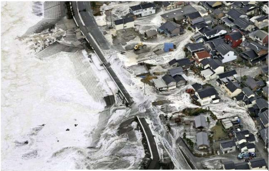
写真Ⅱ-2-1 護岸を超えて背後集落へ押し寄せる高波
