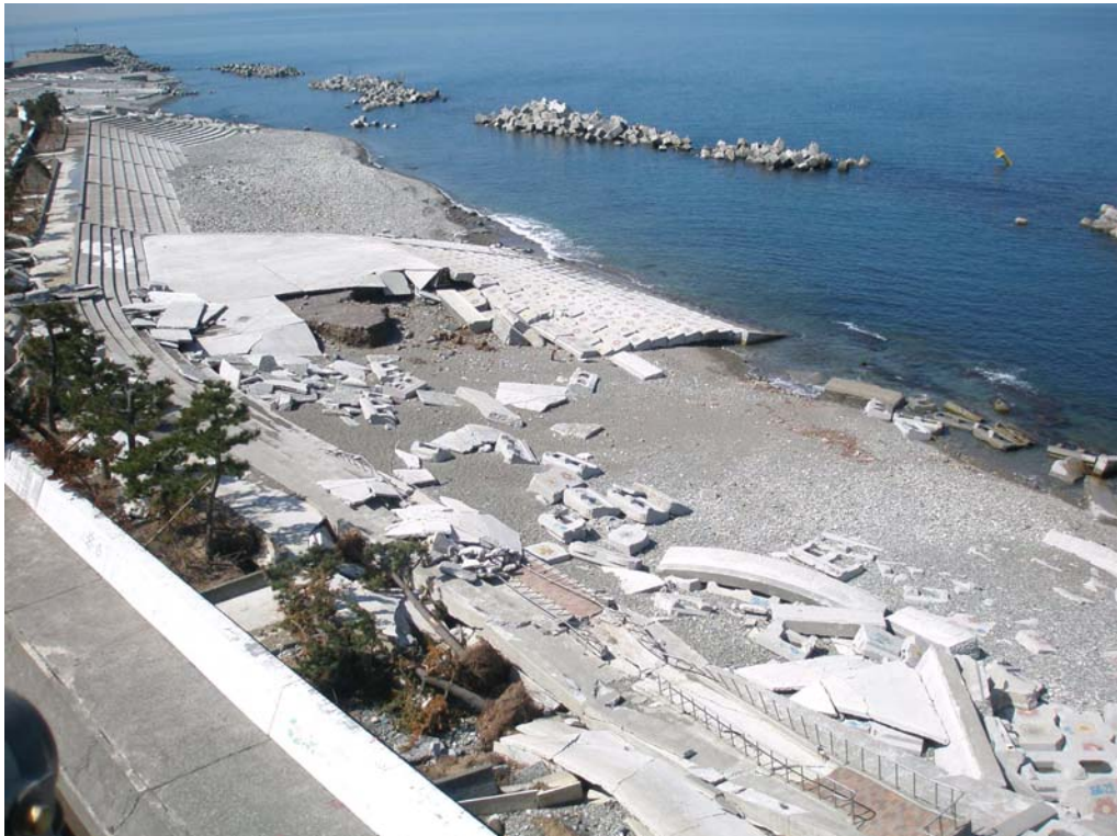
写真Ⅱ-2-5 海岸保全施設の被災状況
