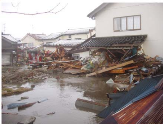
建物・家屋の損壊
