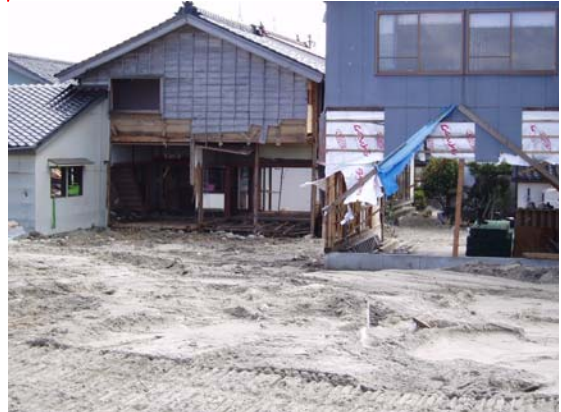
建物・家屋の損壊
