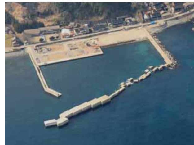
防波堤の滑動・転倒(北小浦漁港)
