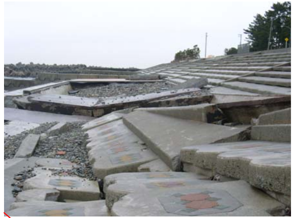
緩傾斜護岸のブロックの散壊
