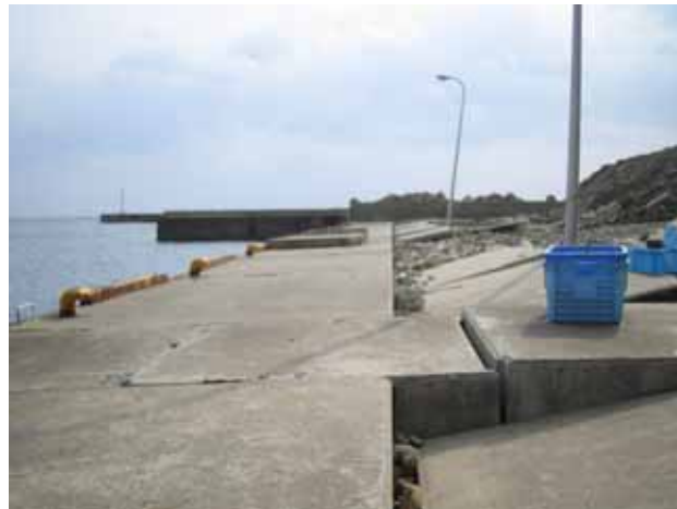
岸壁の破損(水津漁港)
