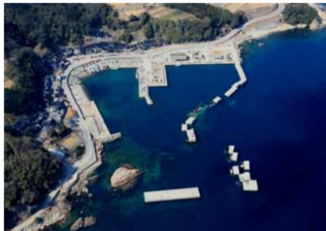
防波堤の滑動・転倒(水津漁港)
