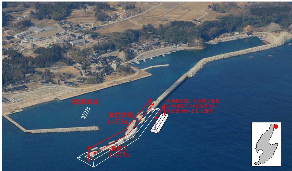
図 V-1-2 新潟県鷺崎漁港の災害復旧事業の内容
