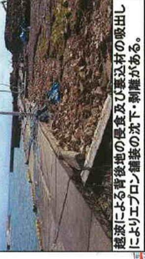
越波による背後地の侵食及び裏込材の吸出しによりエプロン舗装の沈下・剥離がある。
