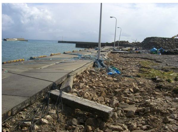
岸壁エプロン・照明灯の破損
